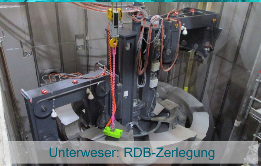
Unterwaser: Demontage RDB-Einbauten
